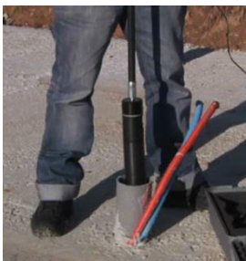
Inspection verticale avec canne de ramonage
